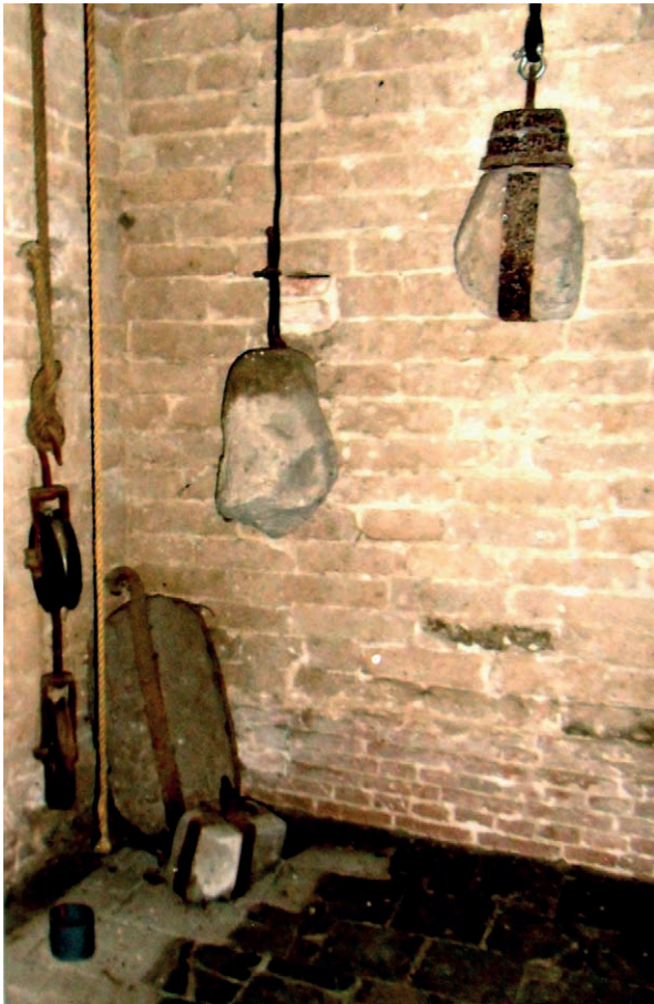
Afb. 13 De originele natuurstenen aandrijfgewichten en katrollen zijn nog aanwezig.
