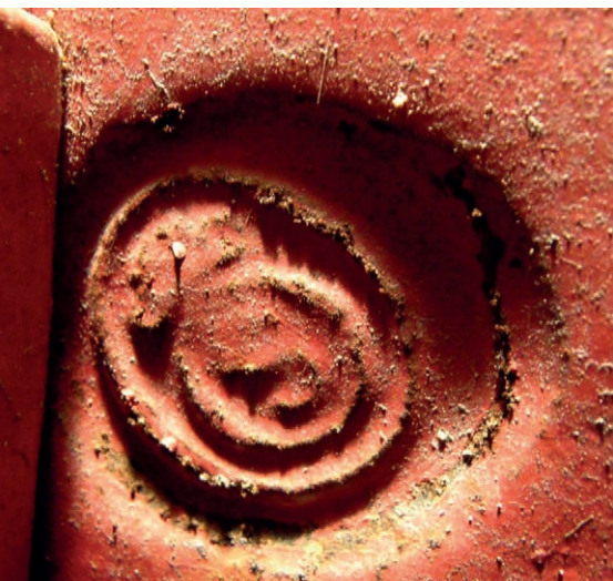
Afb. 8 Een ijzermerk door de fabrikant van het ijzer aangebracht.
