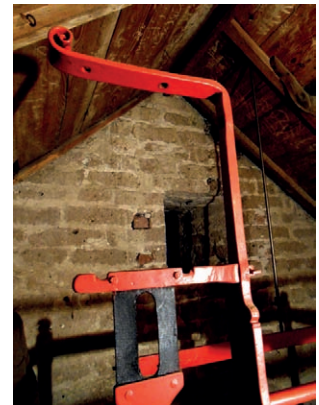
Afb. 7 De slingerophanging is in het verleden gewijzigd.
